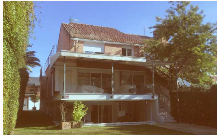
Reforma de vivienda, Calle Arándiga, Aravaca
