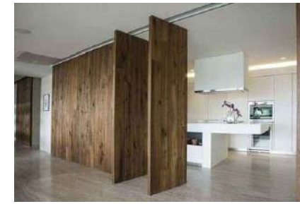
Tabique móvil conformado por paneles individuales.
